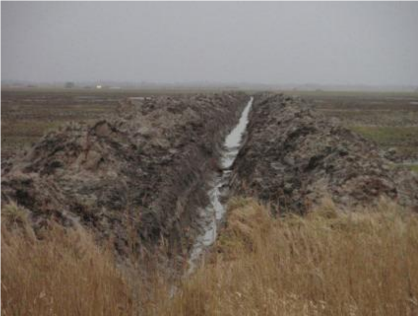
Udgrøftning ved Bjerrum i Ribemarsken, 2008.
