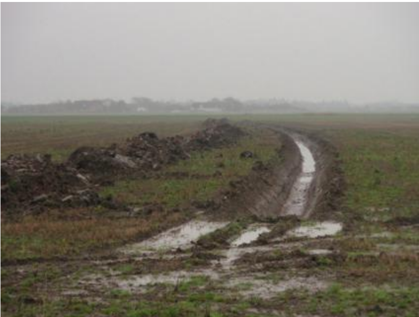
Udgrøftning ved Ydre Bjerrum i Ribemarsken, 2008.
